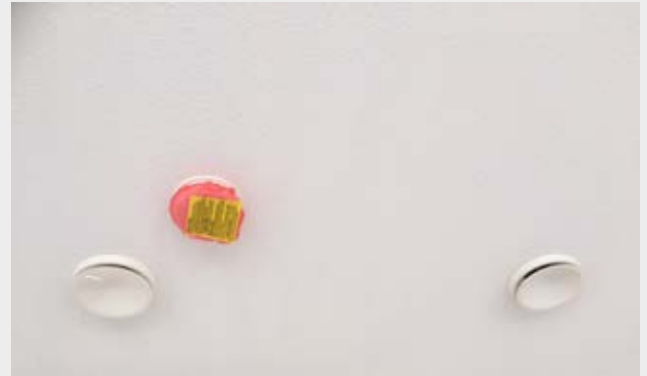
WTW (warmte terugwin) ventielen en de rookmelder in het plafond.
