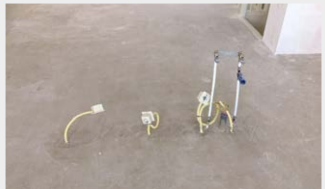
Aansluitpunten voor de keuken uit de vloer voor een kookeiland.
