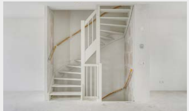
De vuren trap wordt tijdens de bouw gebruikt. In de traptreden kunnen gebruikerssporen zichtbaar zijn. De trap is niet geschikt om direct te schilderen. Voor het beste resultaat kies je na oplevering om de trap te bekleden.
